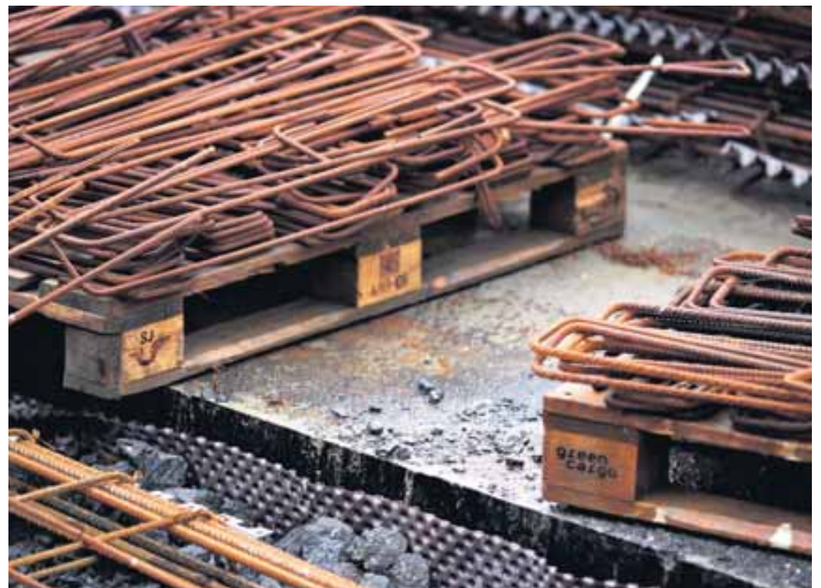
Smíðajárn sem bíður eftir að vera sett á sinn stað.
