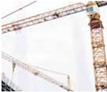
Háir kranarnir nema við himininn.
