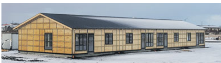
Eitt af raðhúsunum sem er í byggingu á Hellu.
