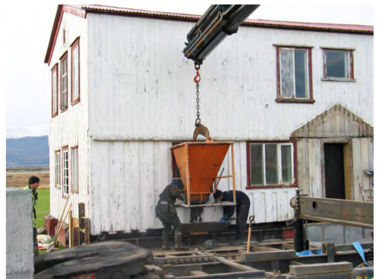
Verið að laga undirstöður hússins á gamla veiðihúsinu fyrir skömmu. Mynd / Atli
