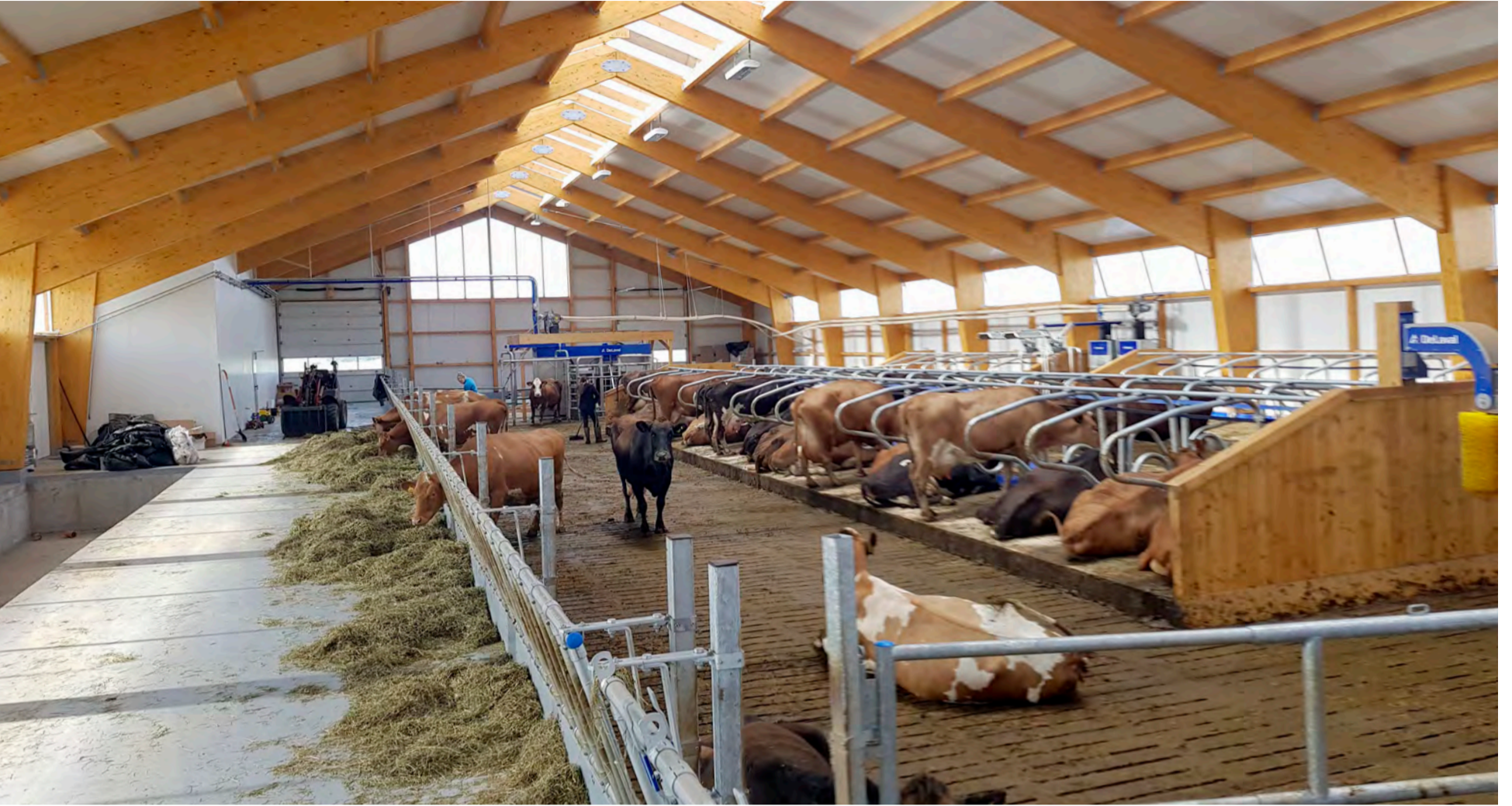
Nýja fjósið á Litla-Ármóti er bjart og fallegt og það fer einstaklega vel um kýrnar þar. Burðarvirki og steinullareiningar eru frá Límtré Vírnet en Fóðurblandan útvegaði innréttingar og mjaltabúnað. Myndir / Magnús Hlynur Hreiðarsson
