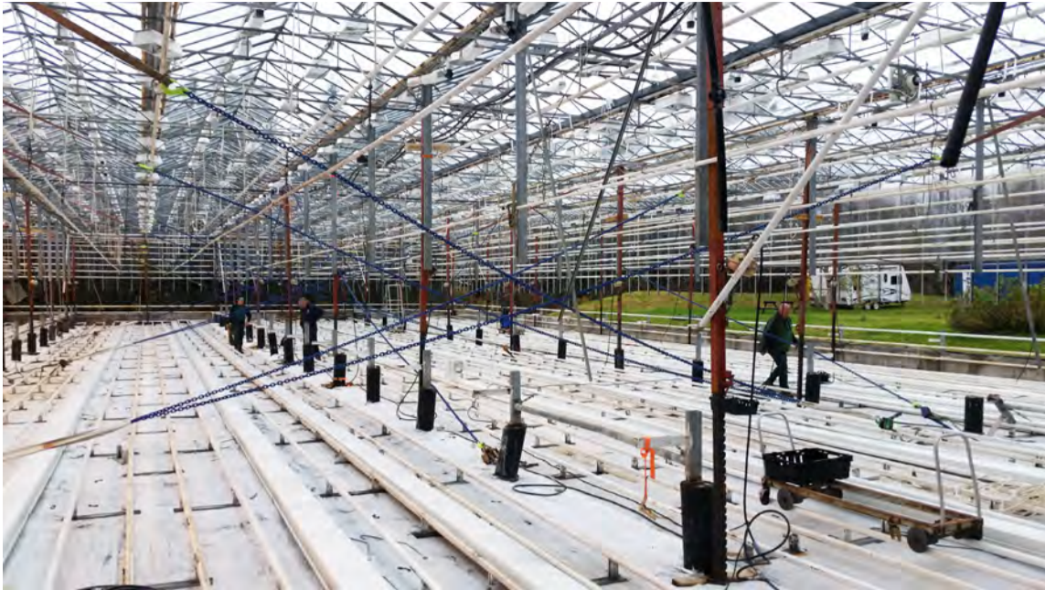
Í samstarfi við við hollenskt fyrirtæki, TC Dool, hefur NPK getað boðið garðyrkjubændum að hækka gróðurhúsa-byggingar til að auka notagildi þeirra. Hér er verið að hækka 1.400 fermetra gróðurhús í Friðheimum. Mynd / NPK
