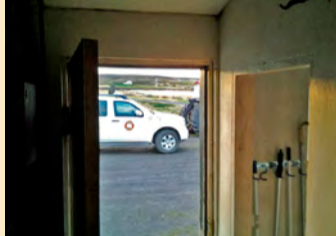
Almennt vantaði út/exit ljós við útganga.
