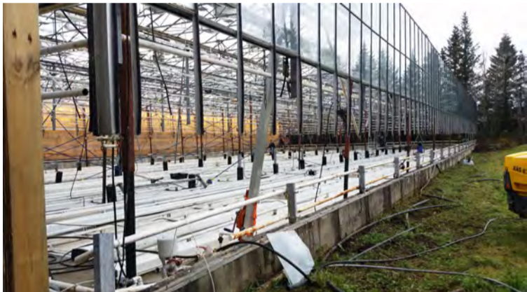
Húsin eru hækkuð um 1,5 metra án þess að hreyfa þurfi við ljósabúnaði eða öðrum lögnum í þaki. Mynd / NPK
