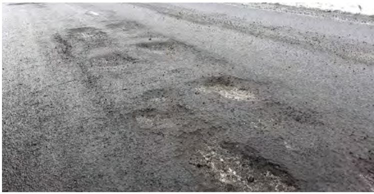
Saltið leysir upp tjöruna í slitlaginu og umferðin þyrlar síðan upp mölinni og sandinum og eftir standa hættulegar holur.
