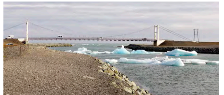
Brúin yfir Jökulsá á Sólheimasandi, en þar er fyrirhugað að setja tvíbreiða brú.
