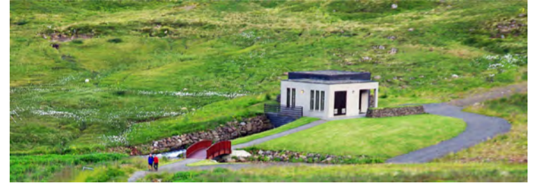
Smávirkjun Orkubús Vestfjarða í Tungudal í Skutulsfirði. Hún nýtir hluta þess vatns sem rennur úr berglögum í Vestfjarðagöngum. Mynd / HKr.
