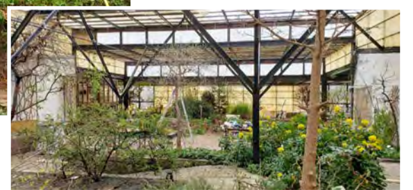
Plöntum úr skálanum var komið í geymslu á meðan endurbygging hans fer fram.
