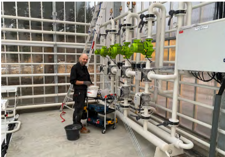
Starfsfólk Friðheima hefur verið í óða önn við að gera nýja gróðurhúsið klárt. Hér er rafvirkinn, Helgi Guðmundsson í Hrosshaga, að tengja dælukerfi hússins sem er mjög öflugt.
