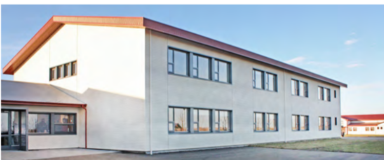
Nýja varmadælan mun væntanlega lækka upphitunarkostnað skólans um 60 til 70 prósent á ári. Mynd / MHH
