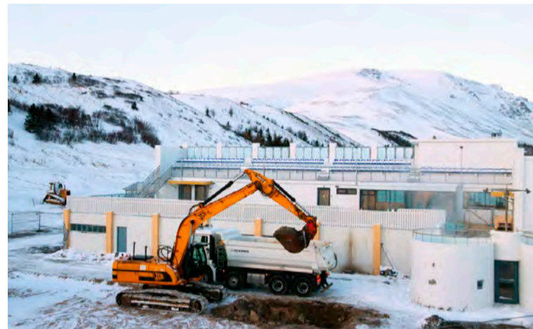
Framkvæmdir við stækkun Sundlaugar Sauðárkróks hófust um miðjan janúar. Fyrirtækið Vinnuvélar Símonar sá um jarðvegsvinnu sem lauk nýverið.
