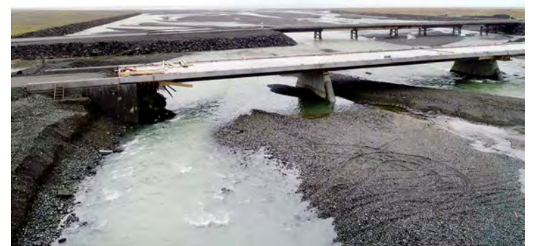
Steinavötn, nýja brúin í byggingu, bráðabirgðabru í baksýn.
