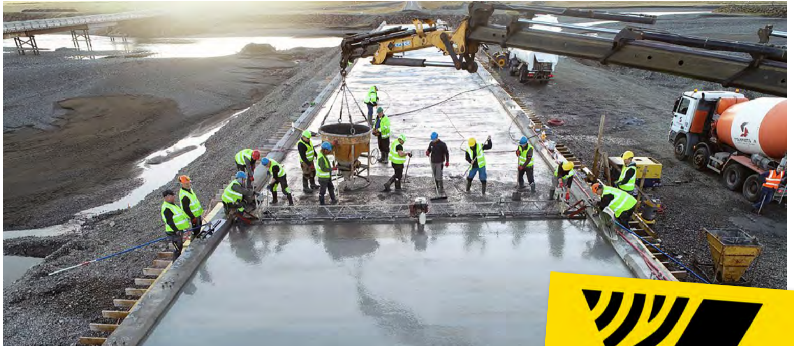
Steypuvinna við Steinavötn.
