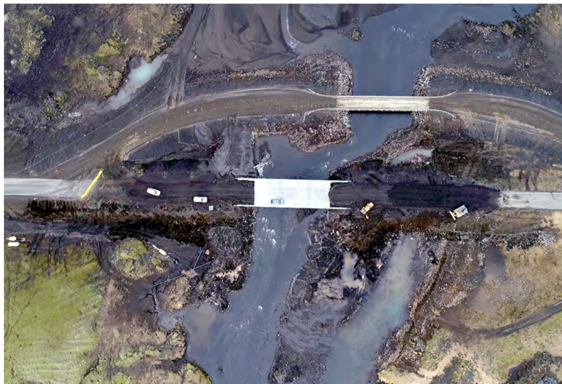
Bráðabirgðabru og ný brú yfir Brunná.
