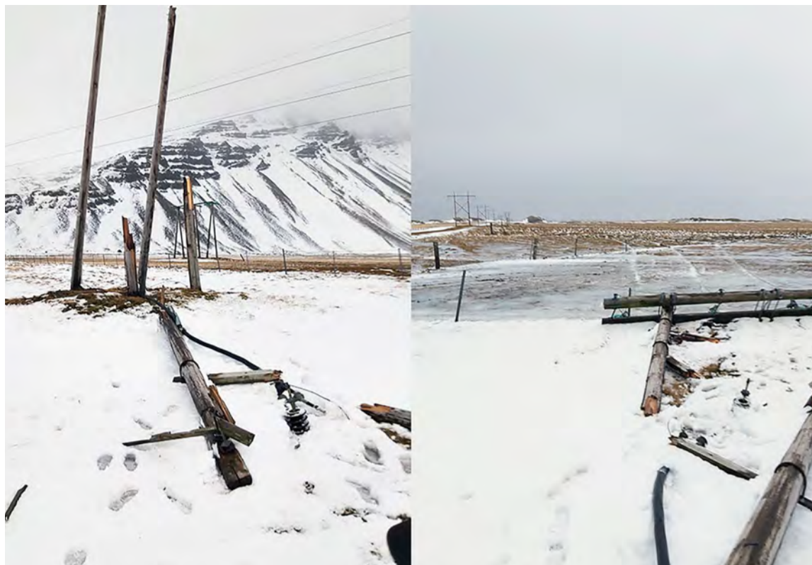
Endamastur á 11 kV línu sem liggur frá Hölum niður á Höfn sem brotnaði í febrúar 2020.
