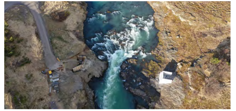
Unnið hefur verið að því að steypa undirstöður undir gömlu Blöndubrúna en hún mun eftirleidis þjóna þeim sem ganga út í náttúruparadísina Hrútey á Blöndu við Blönduós.
