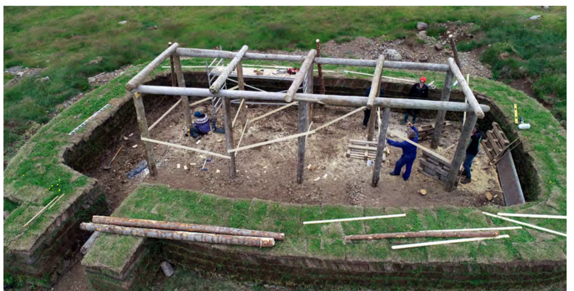
Burðargrindin er nú komin upp og búið að rífa stóran hluta rekavíðsins í rafta sem eiga að fara á þakið.
