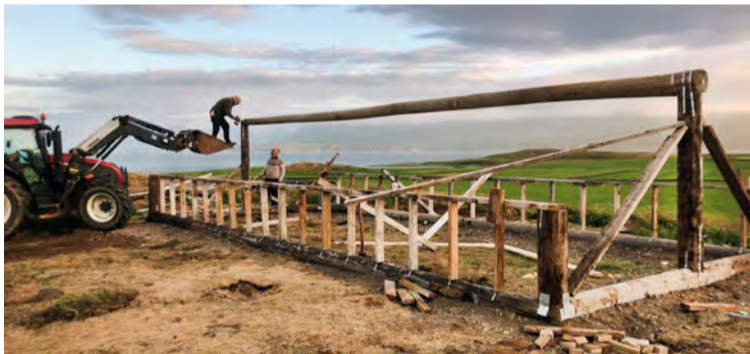
Efniviður í húsbýgginguna kemur héðan og þaðan, m.a. má þar finna gamla aflagða rafmagnsstaura úr Bárðardal.
