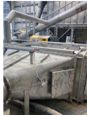
Hitinn úr útblæstrinum er endurnýttur og næst þar 300 kw orka.
