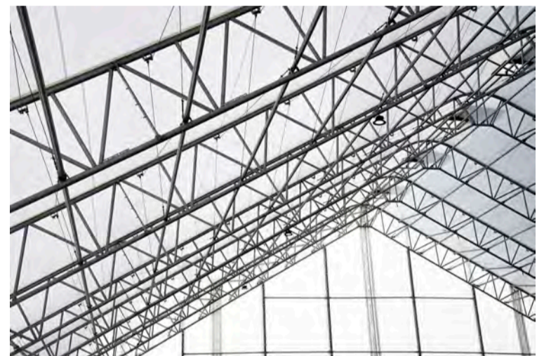
Vegna þess hve dúkurinn er léttur, er þakbyggingin einnig léttbyggð.
