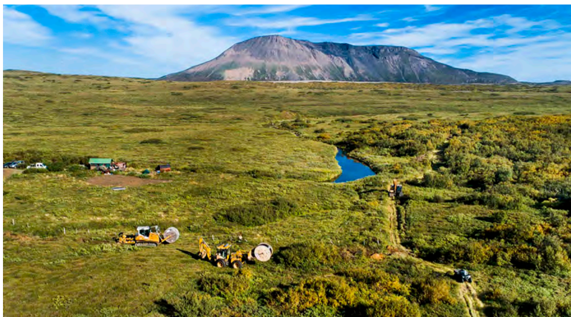
Plægningaflokkur á vegum RARIK að störfum í Öxarfirði.
