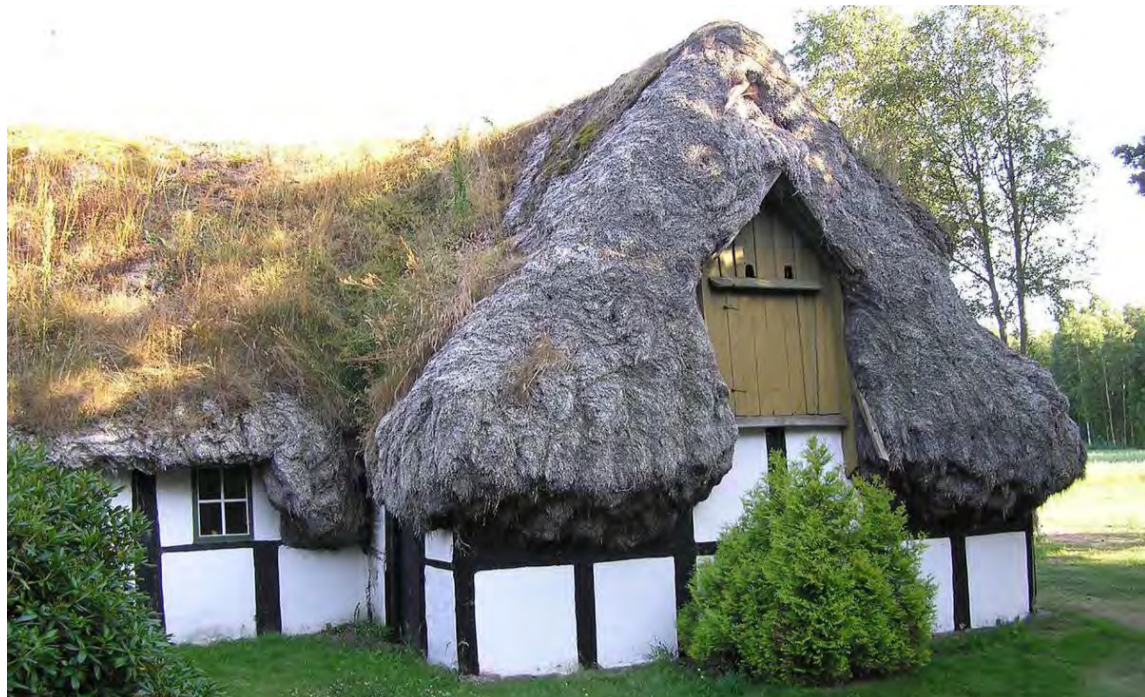
Hálmgras er nýtt sem efsta lag þaks.
