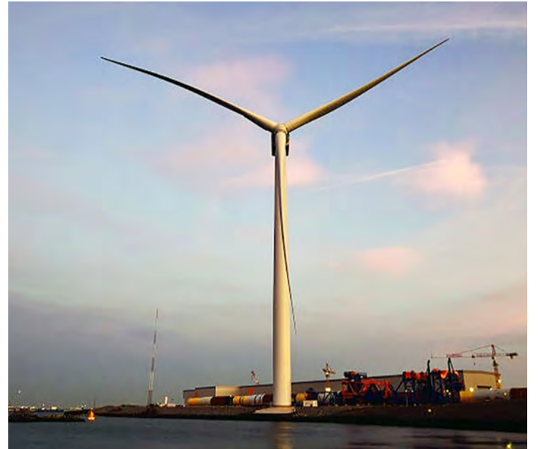
Frumgerð Haliade-X vindmyllunnar frá General Electric. Hún er gefin upp með 14 megawatta afli og 60-64% orkunýtni sem þýðir í raun að vindmyllan á að geta skilað 8,96 MW að meðaltali sem þýkir mjög gott í þessum bransa. Þvermál spaða er 220 m. Til að anna raforkugetu Datteln 4 kolaorkuversins í Þýskalandi þyrfti um 118 slíkar vindmyllur og þokkalega stöðugan vind.
