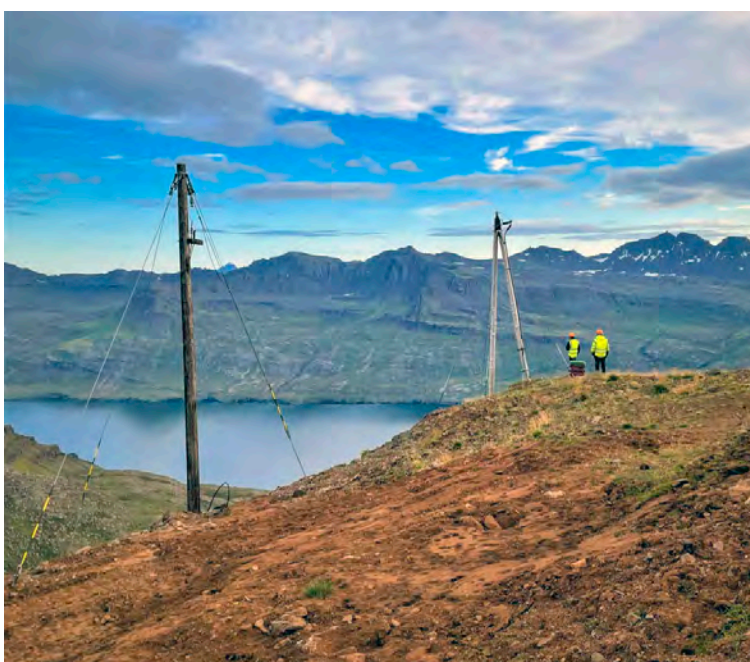
Strengurinn var plægður upp allan Austdal Seyðisfjarðarmegin. Mynd / RARIK
