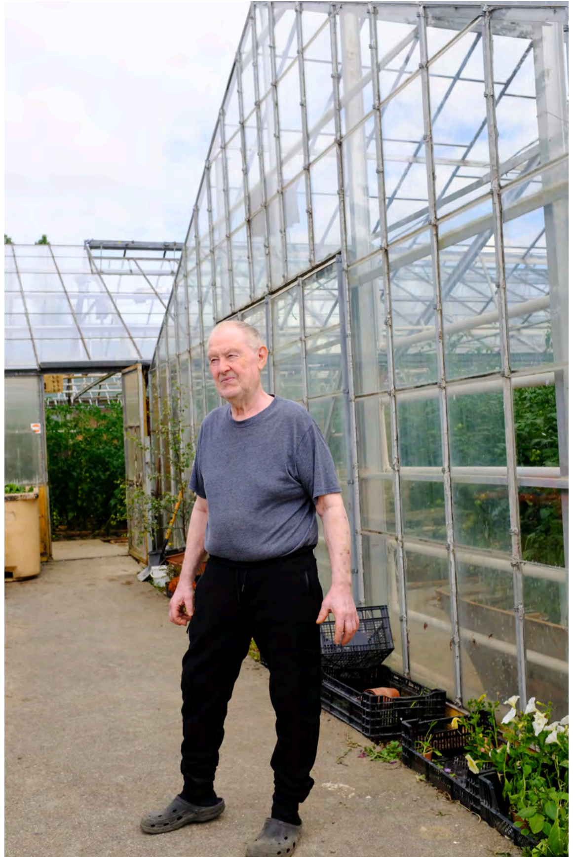
Sveinn byggði eigin gróðurhús eftir teikningum frá Byggingastofnun landbúnaðarins, en hafði þau enn sterkari en þar var gert ráð fyrir. Meira járn er í húsunum, fleiri langbönd og sterkara gler.
