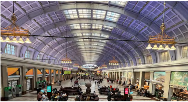
Aðalrestastöðin í Stokkhólmi var byggð 1871 og er burður þaksins límré.
