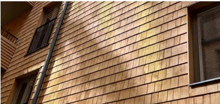
Viðarskífurnar eru glæsilegar á húsinu. Aldagömul aðferð við að klæða hús sem stenst allar kröfur nútímabygginga.
