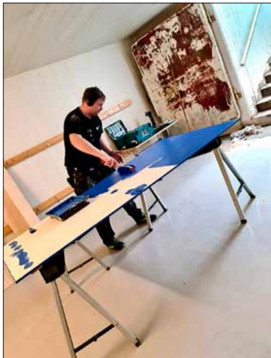
Unnið við framkvæmdir.
