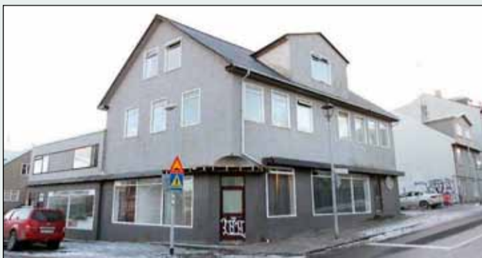
Bræðraborgarstígur 1 áður en húsið brann til kaldra kola.
