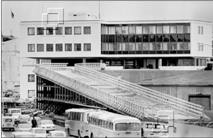
Á Hafnartorgi um árabíl. Steinrampur var byggður upp á Tollhúsið til að nota millihæð þess fyrir bílastæði. Engum kom til hugar að byggt yrði á þessu óhirta svæði borgarinnar.
