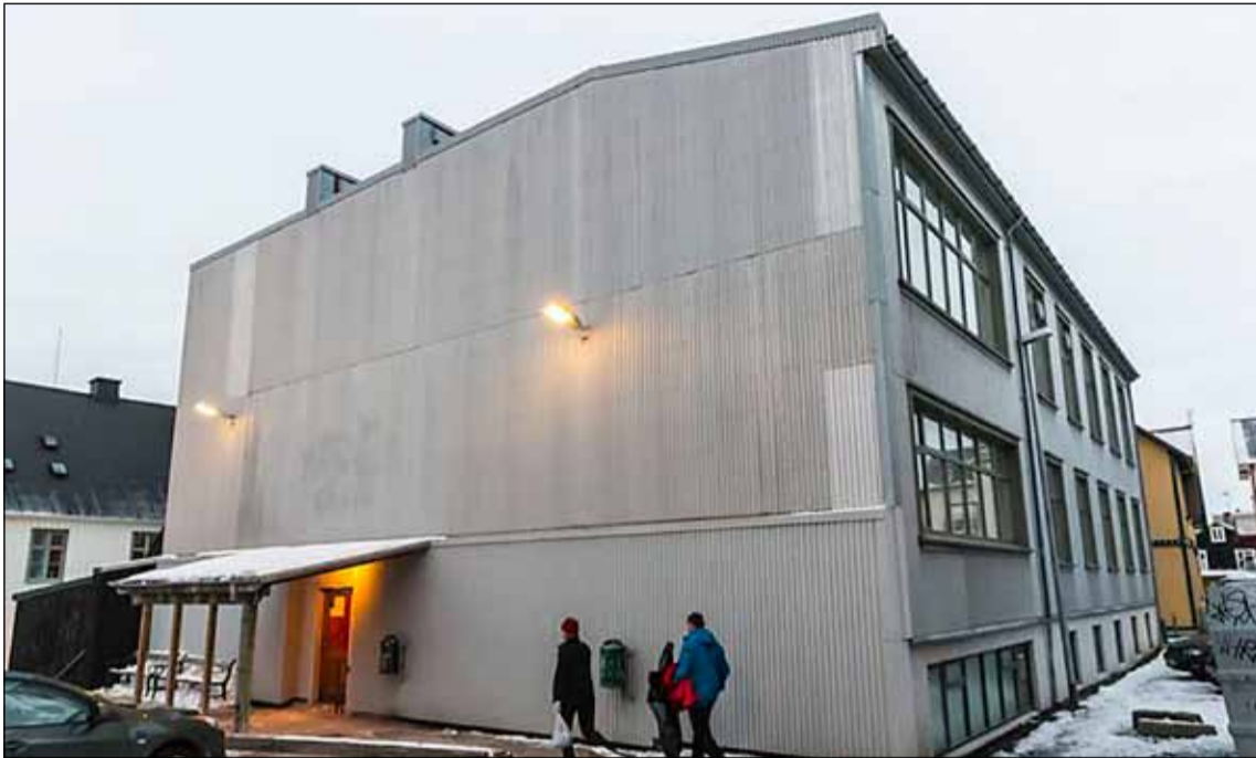
Casa Christi eða hús guðs við Amtmannsstíg var byggt 1907 og er talið ónýtt.
