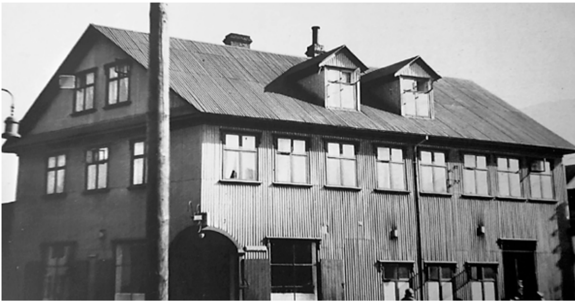
Bræðraborgarstígur 1 eins og húsið leit út á fyrri árum.
