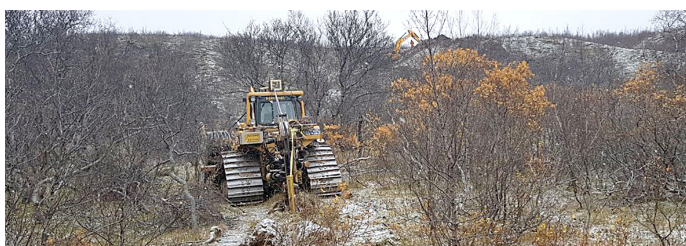
Rafstrengnum úr Húsadal í Þórsmörk yfir í Langadal og að Básun á Goðalandi var valin leið sem raskaði skóginn sem minnst. Þegar rafmagnnið hefur verið tengt sparast um 12.000 lítrar af olíu á ári og allmikil gas með tilheyrandi samdrætti í losun koltvísýrings. Ekkert varanlegt rask varð vegna framkvæmdanna. Ljósmynd: Stefán Jökull Jakobsson.
