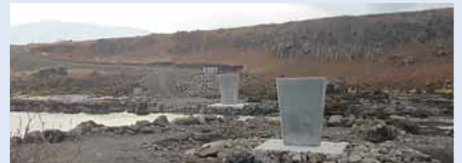
Vinnu við nýja reið- og göngubrú yfir Þjórsá miðar vel áfram. Staðsetning er skammt frá Þjófafossi við Búrfellsskóg. Lokið hefur verið við uppsteypu brúarstólpanna. Landsvirkjun kostar framkvæmdina sem mótvægisáðgerð. Verkefnið er unnið í góðu samstarfi við sveitarfélögin Skeiða- og Gnúpverjahrepp og Rangárþing ytra. Nánar um málið inni í blaðinu.
