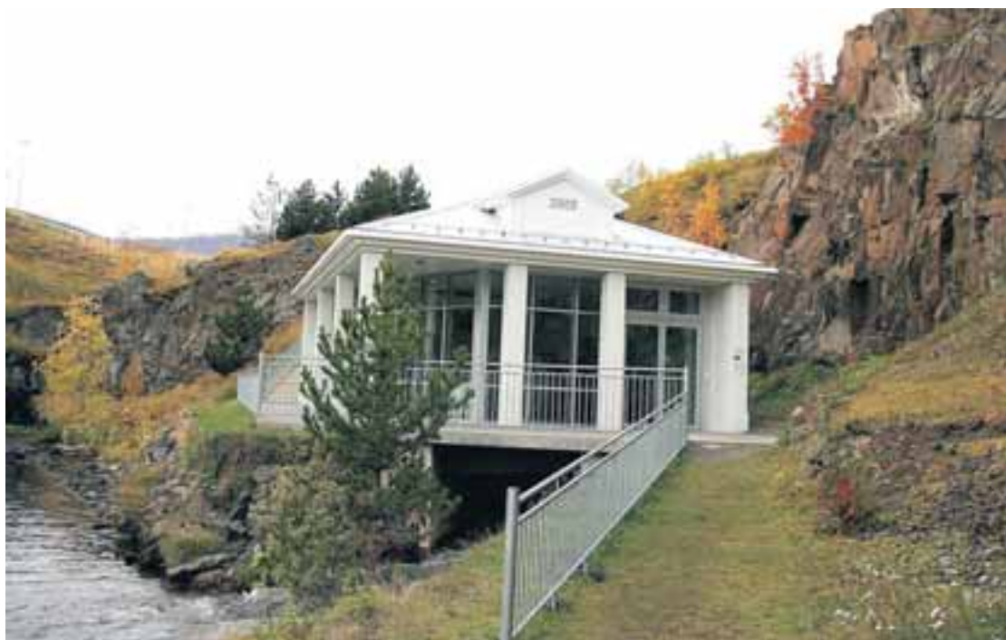
Stöðvarhúsið við Glerá er 80 fermetrar að stærð og byggt á grunni eldra húss.
