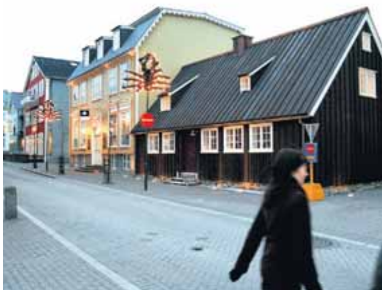
Aðalstræti 10 er eina hús Innréttinganna sem haldið hefur að mestu upphaflegu lagi sínu og telst það því elsta timburhús í Reykjavík. Jón Sigurðsson bjó í þessu húsi á Íslandsferðum á árunum 1857 til 1867. Árið 1895 var sett upp verslun í húsinu og var hún þar allt til ársins 1984.
