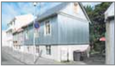
Grettisgata - Miðbær - Einbýli. Húsið skiptist í kjallara, hæð og ris. samtals. 138 fm og 50 fm 2ja herb. hlíðarbyggingu. Búið að taka húsið allt að utan og allir milliveggir komnir upp.
