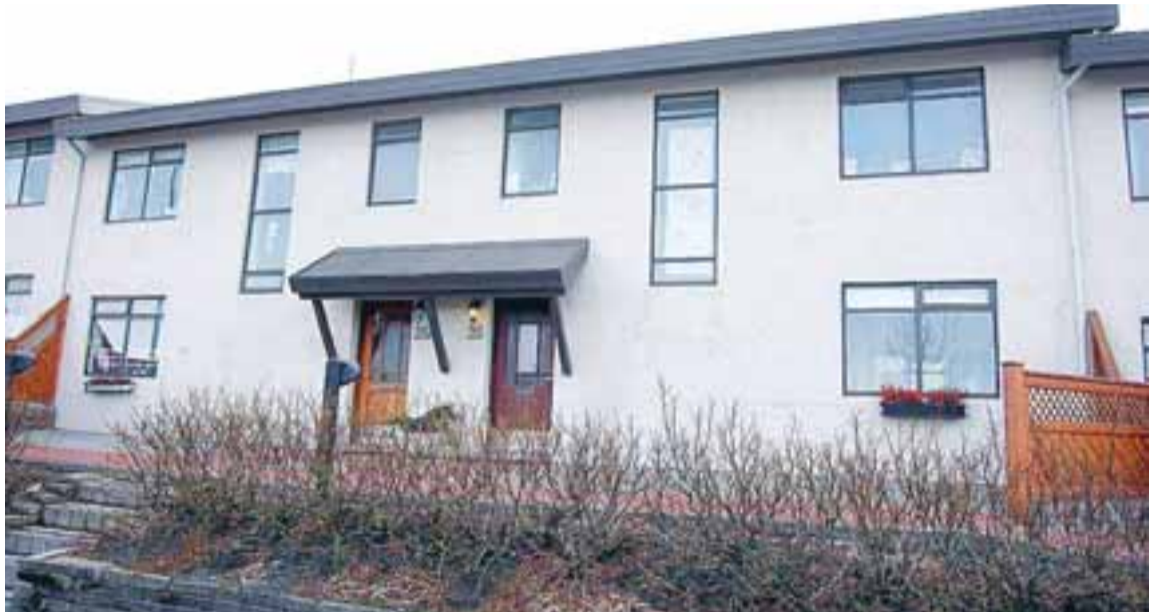
Mikið endurbætt raðhús á Álfhólsvegi og dren og vatnslagnir eru nýlega endurnýjaðar svo og þakfni hússins.
