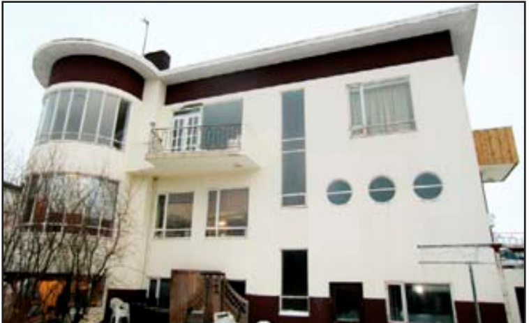
Fallegt talsvert endurnýjuð 4ra herbergja 129 fm íbúð á efri hæð á finum útsýnisstað. Parket. Endurnýjað eldhús. Góðar svalir og mikið útsýni. Tvær íbúðir eru í húsinu. V. 23,5 m. 1092
