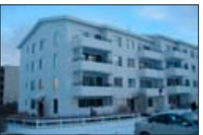
OFANLEITI 3ja herb., Staði í bílageymslu, Nýlega tekið í gegn að utan.
