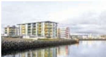
Norðurbakkí - 220 Hfj Nýjar 3ja og 4ra herb. íbúðir sem skilast fullbúnar án gólfefna. Flísar í þvottah. og baði. Staerðir frá 104 - 132 fm. Lyftuhús. Stæði í bílageymslu.
