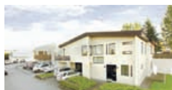
Álfhólsvegur - 200 Kóp 280 fm. fallegt einbýlishús á 2. hæðum með tvöföldum innbyggðum bílskúr. Búið að innrétta hluta bílskúrs sem íbúðarherb.
