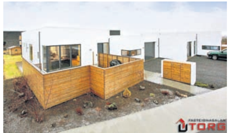
Húsið er staðsteypt og lóðin frágengin en eftir er að helluleggja innkeyrslu.
