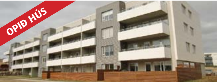
(opið hús borði) Falleg og mjög vel skipulögð 120 fm 4ra herbergja endaíbúð á 3. og efstu hæð í vönduðu fjölbýli ásamt stæði í bilageymslu. Stórar svalir. Fallegt útsýni. Parket og flísar á gólfum. Góðar innréttingar. Opið hús í dag mánudag frá kl 17-18 V. 33,9 m. 1444
