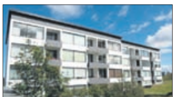
Ásbraut Kóp. - stúdíó. Mjög góð 41,3 fm stúdíóíbúð á 3ju hæð (efstu hæð) í nýmálðu fjölbýlishúsi á besta stað í Kópavogi. Parket og dúkur á gólfum. Verð 12,5 millj.
