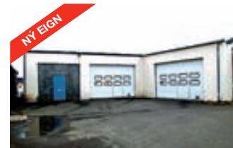
Hjallahraun – 300 fm atvinnuh. Höfum til sölu 296 fm atvinnuhúsnæði á götuhað með c.a. 100 fm milli lofti. Góð lofthæð. Tvennar stórar innkeyrsludyr. Auðvelt er að skipta plássinu upp í tvær einingar. Verð 28,9 millj.
