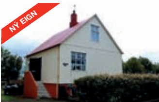
Fossagata – Einbýlishús – Bílskúr Vorur að fá í einkasölu fallegt eldra einbýlishús (timburhús) sem er 104 fm. Kjallari, hæð og ris ásamt fristandandi bílskúr á þessum vinsæla stað í litla Skerjafirði. Fallegur ræktaður garður (eignarlíð). Fallegt lítið einbýli á góðum stað. Verð 41,9 millj.
