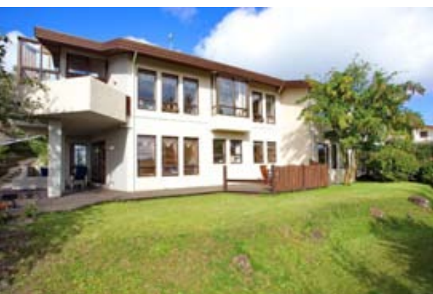
Sérlega falleg og vel viðhaldið, samtals 254,2 fm, 2ja hæða einbýlishús með sér stúdíó íbúð á góðum útsýnisstað innanlega við Hlíðarhjalla. Róleg og falleg gata. Húsið hefur fengið gott viðhald í gegnum tíðina. V. 71,0 m. 1930
