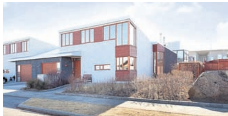
Einstaklega vandað hús í Ásahverfi Garðabæjar.
