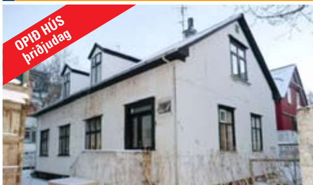
OPÍÐ HÚS þriðjudag 22,6 fm stúdíóíbúð á 1.hæð í eldra járnklæddu timburhúsi sem skráð er byggt 1907. Laus strax, sölumenn sýna Eignin verður sýnd þriðjudaginn 25.mars milli kl. 17:15 og kl. 17:45. V. 8,5 m. 3440
