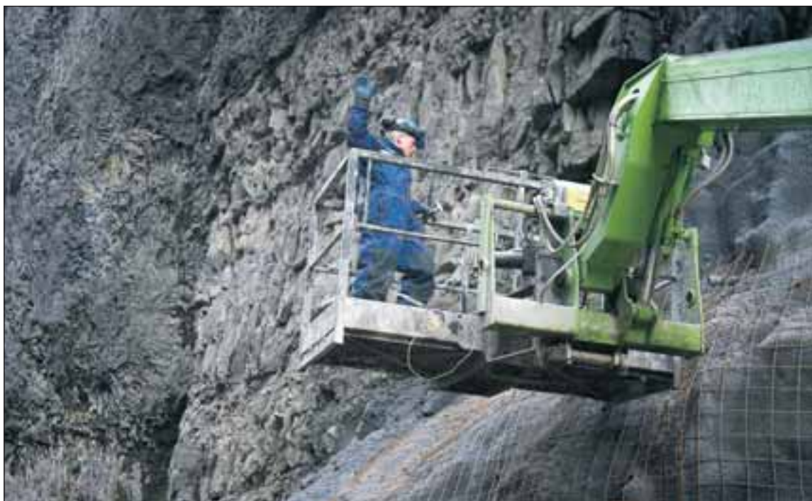
UNNIÐ VIÐ KÁRAHNJÚKA
