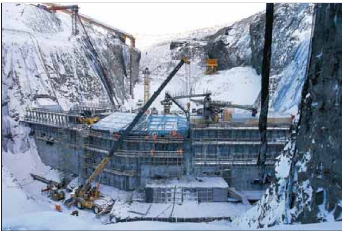
FRAMKVÆMDIR VIÐ KÁRAHNJÚKA Hægt og rólega ris tæveggurinn ofan í gljúfrinu við Kárahnjúka en vinnan hefur tafist um fjóra mánuði. Búið er að reisa tjald yfir vinnusvæðinu á tæveggnum. Svæðið er hitað upp svo hægt sé að steypa. Sjá síðu 6
