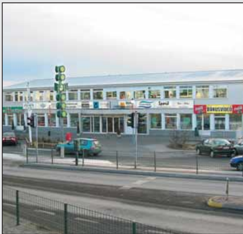
Efstaland 26, Grímsbær Nýtt og glæsilegt skrifstofuhúsnæði á annarri hæð í lyftuhúsnæði. Um er að ræða 350-700 m 2 rými sem býður upp á mikla möguleika.
