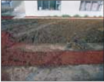
Hér er allt tilbúið undir þökulagningu.
