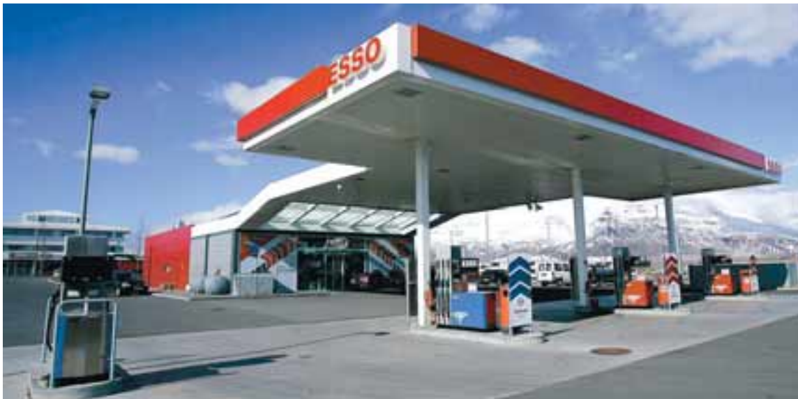
Þak stöðvarinnar rennur út af húsínu og flæðir yfir súlur sem standa við dælurnar.
