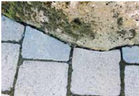
Eitt af því sem krefst mikillar vinnu er sögun. Hér má sjá hvernig hellurnar hafa verið sagaðar að litlum sjávarsteinum.
