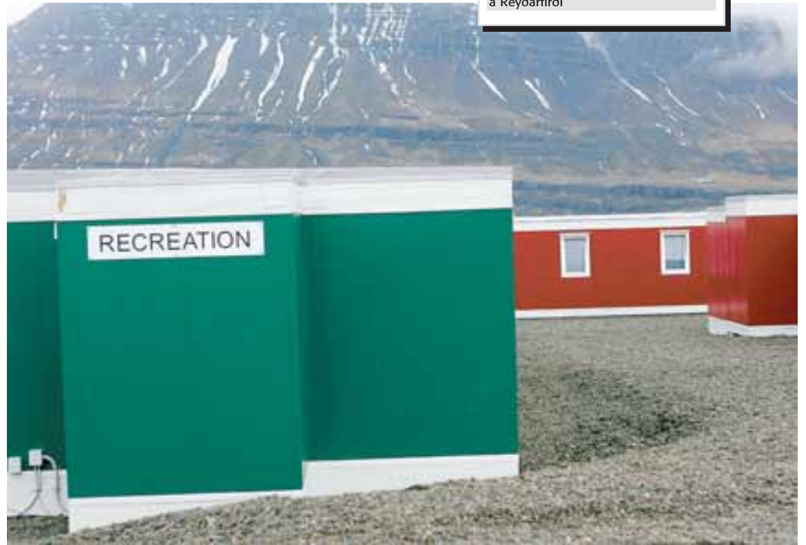
STARFSMANNAPORPIÐ Á HAGA Húsin í starfsmannaþorpinu eru innflutt, traust og snyrtileg og líta vel út. Á húsunum eru merkingar, hér er t.d. afþreying fyrir hendi. Á öðrum stað er mötuneytið, kallað Golden Duck, en það nafn kom til þegar erlendur starfsmaður reyndi að segja Gott kvöld á íslensku.
